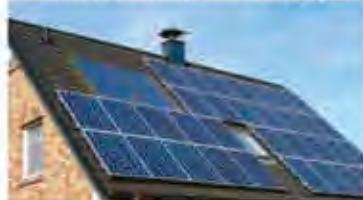
INSTALACIÓN DE PLACAS PARA AUTOCONSUMO
