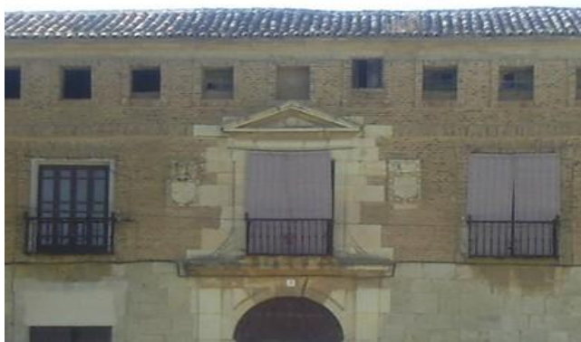
Fachada de la Casa de los Girón
